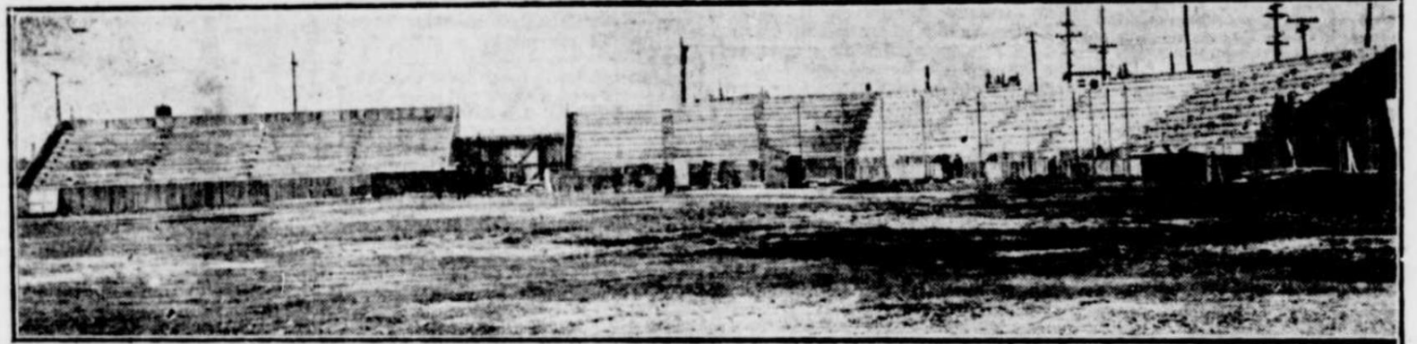
Une vue générale du nouveau parc de baseball Québec au coin de la 3e Ave. et de la 2e rue, montrant la grande estrade et celle des bleachers
